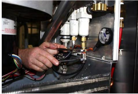
3. Placer une clé 5/8" sur le connecteur situé à côté de l'orifice et une clé 9/16" sur l'orifice. Tourner la clé 5/8" vers la gauche pour retirer l'orifice.
