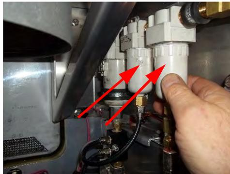
3. Déposer le premier filtre en le tournant vers la gauche. Une fois déposé, monter le filtre neuf en vissant vers la droite.
