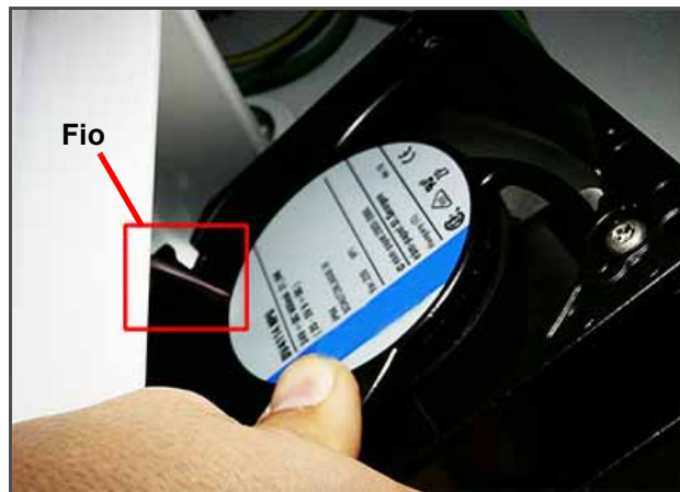
Figura 7.15 Remoção do ventilador do VFD
