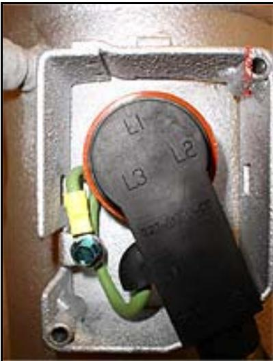
19. Conecte el cable de tierra verde (**Figura 7.10** arriba) a la lengüeta de conexión a tierra ubicada en el interior de la caja de terminales del compresor usando el tornillo autorroscante de conexión a tierra (**Figura 7.5**, artículo #12). Cierre la caja de terminales del compresor usando la tapa de terminales que retiró.
